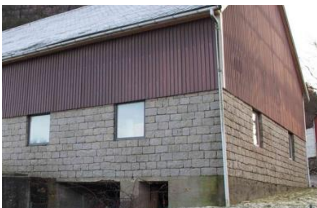
Eksempel på fint murerhåndverk fra 1937, i fjøsmur på en løe på lms
