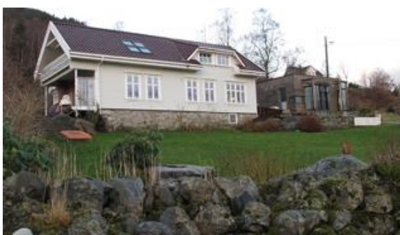
Bersagel skole med ny plassering i 1896. Den er i bruk som bolig og en del endret.
