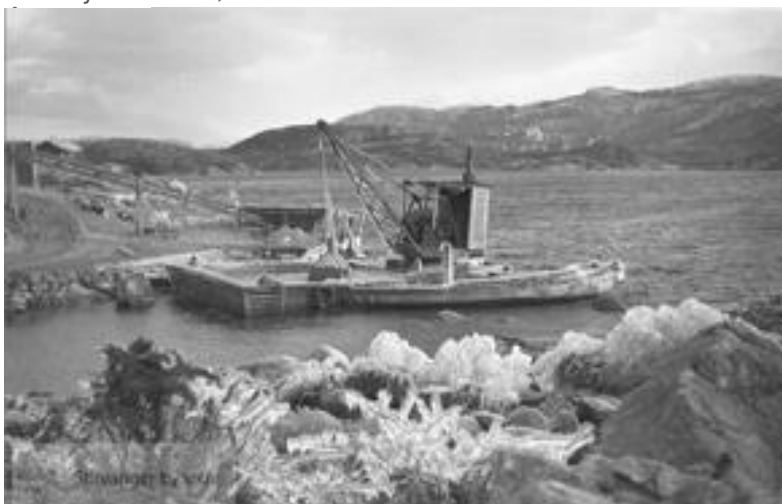
Stavanger Kieselguhr fotografert 1937. I de nye anleggene ved Fløysvik var drifta mer mekanisert og guren tatt opp med mudderprammer og grabb. (Foto av Hans Henriksen. Stavanger
