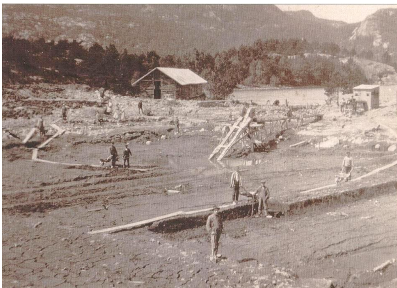
Uttak av kiselgur i den første driftsperioden krevde mye manuell arbeid. Guren ble spadd opp fra bunnen av tørrlagte vann. Sundatjødna 1920, foto Tobias Horve. Bildelkilde Sandnes H.L.
